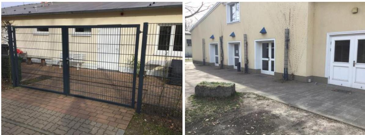
Abbildung 6-4: Überflutungsgefahr durch ebenerdige Eingänge: Kita Falkennest (links) und Kulturhaus Friedrich-Wolf (rechts). Fotos: Hydrotec, 17.03.2020
